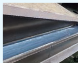
箱樋の補修に
