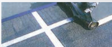
アスファルト防水(トーチ工法、常温工法)下地処理
