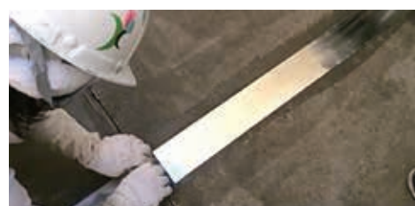
ゴムローラーによる転圧
